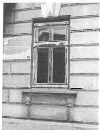
Okno projektowane do wymiany
